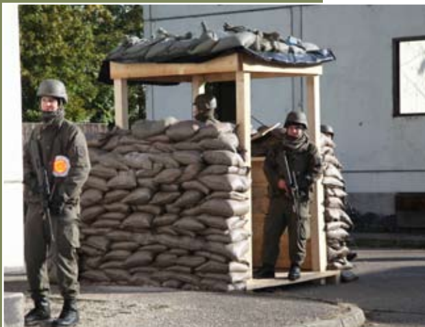
Bilderleiste: Zeigt die Phasen des Aufbaus des Postenunterstands aus Bodenelementen, Seitenteilen und Deckel. Hierbei wurden die Teile direkt von einem 12M18 herunter verlegt. Zu unterst der fertiggestellte, mit Sandsäcken eingedeckte Postenstand im Betrieb.
