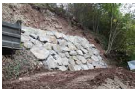
Bilder oben: Zeigen von nachhaltigen, baulichen Maßnahmen zur Hangsicherung. Im Bild oben die Krainerwand und darunter eine Steinschichtung in Frankenfels/ Schrammbach.
