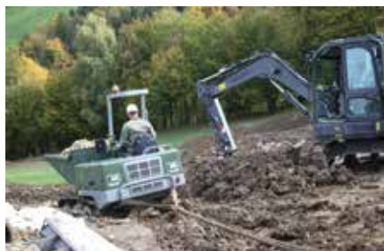
Bilder unten: Zeigen von den Mühen zur Drainagierung der Hänge. In Kirchberg bspw. sichert sich der Fahrer des Kettendumpers durch die Forstseilwinde eines Traktors vor der Steilheit des Hanges.
