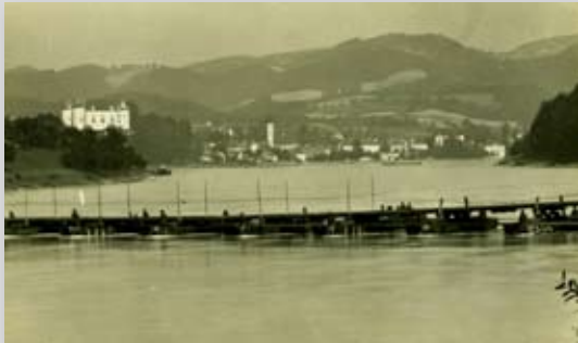
Bilder oben: Manöver der Brigade Oberösterreich Nr. 4 am 28. und 29. August 1929 in Grein an der Donau. In nur 2 Stunden und 25 Minuten hatten die Pioniere die volle Flussbreite mit einer Kriegsbrücke überbaut. Trotz der damals dort herrschenden Strömungsgeschwindigkeit (etwa 4 m/sek) eine Leistung die seinesgleichen sucht.
