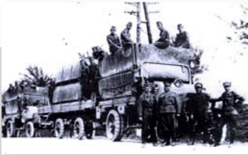
Bild oben: August 1928. Allmählich sollten motorisierte Kraftwagenequipagen an die Stelle bespannter Fuhrwerke treten. Die Übung führte nach Erlauf, dort wurde eine Bockbrücke geschlagen.
