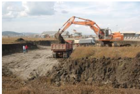
Bild: Aushub von 5000 Kubikmeter für den Unterbau des Umschlagpunktes. Die Arbeiten wurden ausschließlich an lokale Firmen vergeben.
