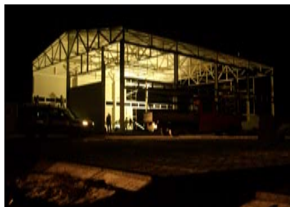
Bild zeigt die bereits verschweißte Stahlkonstruktion und den Beginn der Dacharbeiten. Von Anfang September bis Mitte Dezember des Vorjahres entstand die Halle gemeinsam mit der Manipulationsfläche am Flughafen von Pristina.
