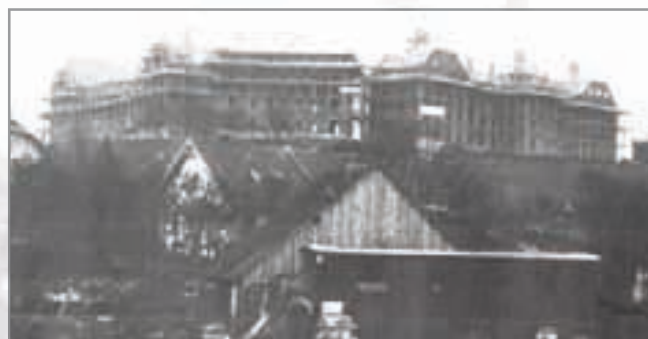
Bild: Abschlußarbeiten am Rohbau im August 1913
