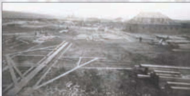
Bild: Bauarbeiten im August 1912
