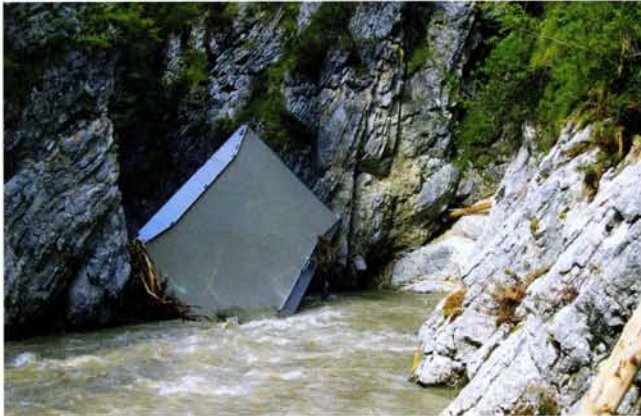
Die verkeilte Hohlkastenbrücke vor ...
