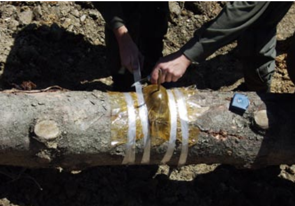
MELKer Pioniere beim Laden von Sprengstoffmitteln.
