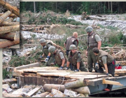
③ Abbau einer zerstörten Behelfsbrücke
