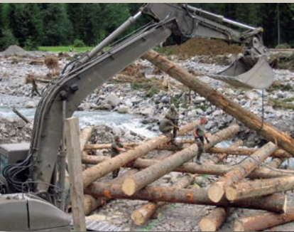
③ Uferbefestigung durch RAUH-BÄUME um das Auswaschen eines Schutzdammes zu verhindern.
