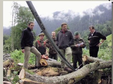
⑤ Spannen einer Wasserleitung mittels Befestigung an Stahlseil - spannen mittels Motorwinde und Greifzüge. Das Problem: Unzugängliches Gelände (sämtliches Material mittels HS eingeflogen) Hochalpines Gelände (Unterstützung durch Heeresbergführer)
