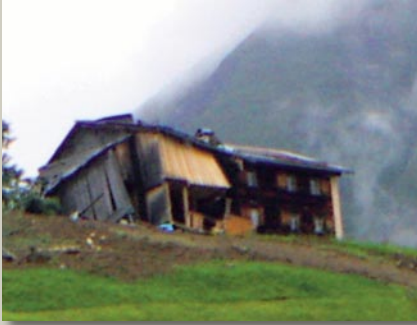
① Links: Sicherung eines Wohngebäudes gegen Abrutschen. Das Wirtschaftsgebäude ist durch eine Mure schon teilweise beschädigt, dadurch besteht Einsturzgefahr für das gesamte Gebäude. Maßnahmen: Trennen von Wirtschafts- und Wohntrakt durch zerschneiden der Verbindungsbalken mittels K-Säge. Rechts: Einbau von Abstützungen am Wirtschaftstrakt um Einsturz zu verhindern
