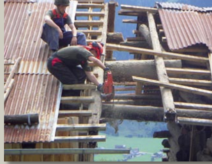
① Links: Sicherung eines Wohngebäudes gegen Abrutschen. Das Wirtschaftsgebäude ist durch eine Mure schon teilweise beschädigt, dadurch besteht Einsturzgefahr für das gesamte Gebäude. Maßnahmen: Trennen von Wirtschafts- und Wohntrakt durch zerschneiden der Verbindungsbalken mittels K-Säge. Rechts: Einbau von Abstützungen am Wirtschaftstrakt um Einsturz zu verhindern
