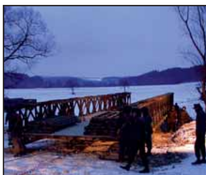
Der Abbau dauerte bis spät in die Nacht.
