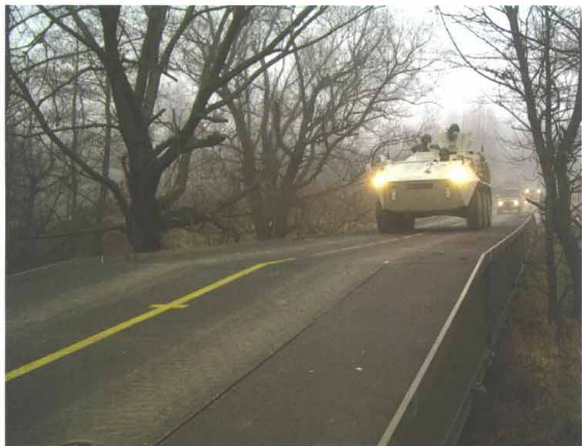
Die Pionierbrücke 2000 (PiBr 2000) im Einsatz mit schwerer Last
