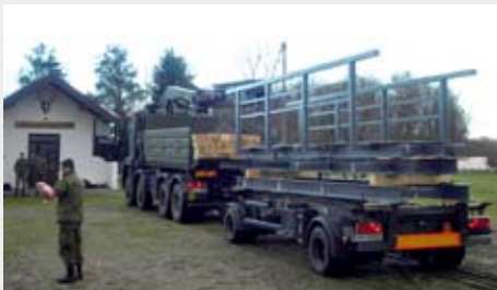
Bilderleiste oben zeigt das Werden der sieben Meter langen Behelfsbrücke im bosnischen Derventa.
