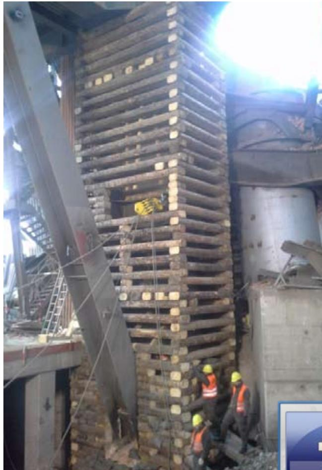
**Bilder:** Zeigen das Sprengobjekt vor bzw. nach der Sprengung.
