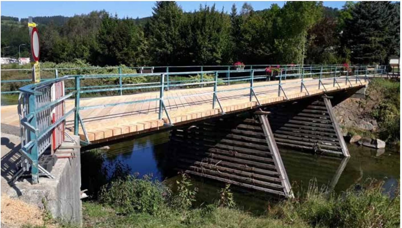
Die Unterstützungsleistung mit hohem Ausbildungswert erfolgte auf Antrag der Gemeinde. Dabei mussten auf die Gesamtlänge der beiden Brücken die Tragbeläge sowie die Zwäng- und Rodelbalken entfernt und ersetzt werden.
