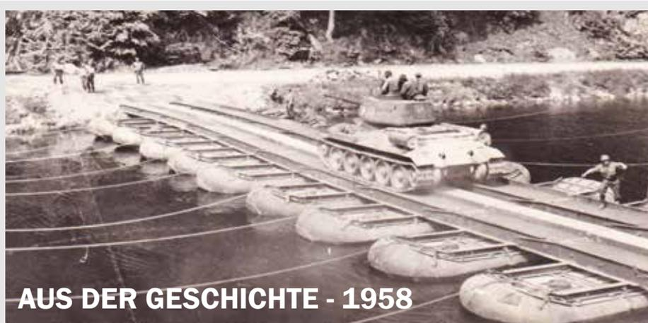
**Das Bild** entstand am 28. Mai 1958 und zeigt Melker Pioniere bei den Frühjahrsmanövern am Kampfluss im Waldviertel. Klar erkennbar ist die Schlauchbootfähre mit M2-Spurtafeln beim Übersetzen eines Kampfpanzers T34.
