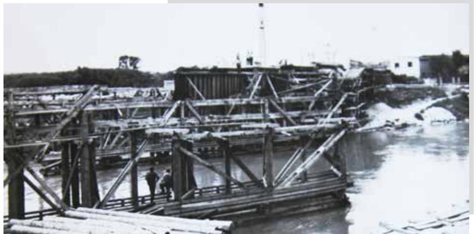
**Bild oben:** Zeigen vom wohlüberlegten und gut vorbereiteten Einsatz der Melker Pioniere beim Einheben der fünf je 16 Tonnen schweren Stahlträger. Dazu wurden kurzerhand zwei Schwimmkähne miteinander verbunden und punktgenau eingeschwommen. So konnte der damals moderne 24-Tonnen-Autokran die Teile Stück für Stück platzieren.
