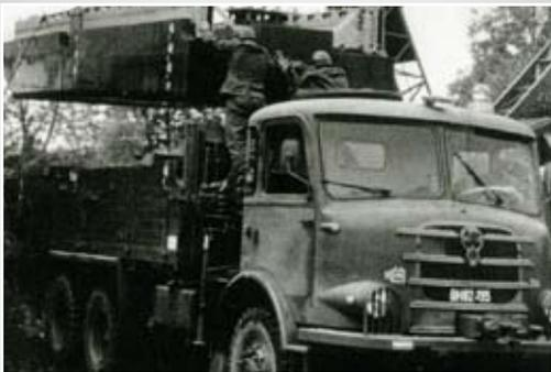
**Bild:** Das damals brandneue Alu-Gerät beim Bau über die Ybbs. Im Oktober 1971 bestand die Pontonbrücke ihre Feuertaupe. Daraus erwachsen bis heute mannigfaltige Verwendungsmöglichkeiten.
