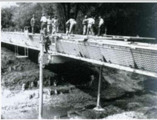
**Bild oben:** Im September 1972 erprobten Pioniere der 1. Kompanie in Korneuburg diese Krupp-Trogbrücke. Das Profil, aus koppelbaren Modulen mit Rampenteilen, ähnelte bereits damals einer modernen Faltfestbrücke. Dieses System (mit Ausnahme der Pendelunterstützung) war beim Bundesheer aus verschiedenen Gründen nie eingeführt und das Bild gilt daher als echte Rarität (Archiv PiB3).
