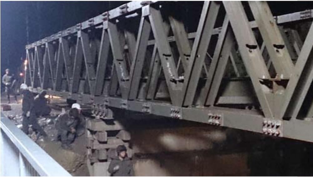
Pioniere der Übersetzkompanie rückten in der 46. Kalenderwoche aus, um im Inneren Salzkammergut eine knapp 35 Meter lange Ersatzbrücke abzubauen. Zudem verlangte der Auftrag eine weitere Ersatzbrücke (knapp 20 Meter lang) neu aufzubauen.
