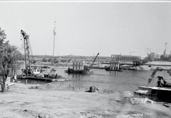
**Bild:** Mit den Vorbereitungen zum Bau der Ersatzbrücken wurde sofort begonnen. Das notwendige Gerät konnte durch logistische Glanzleistungen aus dem gesamten Bundesgebiet antransportiert werden. Knapp 45 Tonnen Gerät kamen aus Deutschland.
