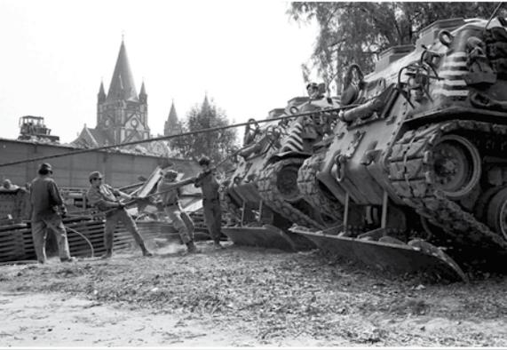
**Bild:** Das Heer musste zum Einsatz kommen. Brückenreste wurden mit Bergepanzern geborgen, große Teile mit Sauerstoffflanzen zerschnitten oder einfach gesprengt.
