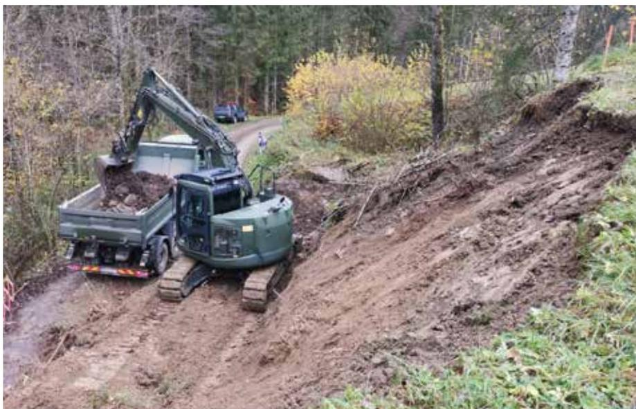
**Bilder** zeigen den gefährdeten Straßenabschnitt. Die Melker Pioniere machten in der ersten Phase ein Befahren der gesperrten Straße wieder möglich.
