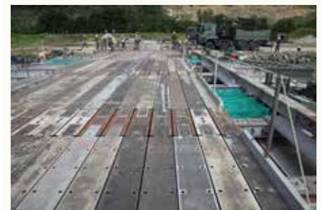
**Bilder ober- und unterhalb:** Zeigen vom Bau der aus 16 Hauptträgersträngen und sieben Ganzpontons bestehenden frei fahrenden Fähre. Das Eigengewicht des miteinander verbundenen Alu-Baukastensystems liegt so bei etwa 64 Tonnen.
