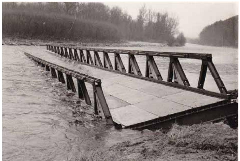
So verlegte in der Vorwoche des Brückenbaues ein Pionierzug der 1. Kompanie um ein doppelwandiges Pfahlloch für die Vorschubphase zu bauen und am 17. 10 begann der eigentliche Bau. Die Kriegsbrücke aus D-Gerät wurde einstöckig, einwandig verstärkt gebaut und war 54,90 Meter lang. Am 19. 10. 1979 war die Brücke in Schönegg nahe Günzing fertig gebaut und abgesenkt.
