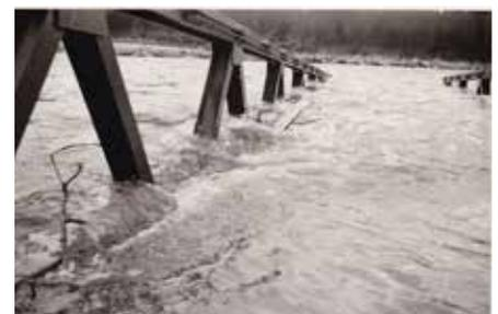
**Bilder:** Zeigen von der RVÜ 79 bzw. von der Bergung und dem Abbau der Brücke über die Ybbs. Nach dem Hochwasser schauten nur zwei oder drei Felder aus dem Wasser. Diese waren zudem stark mit Schwemmholz verkleast.
