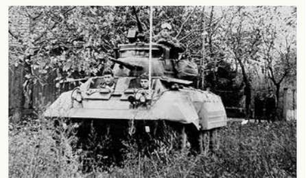
**Bilder:** Zeigen den M 8 der ersten Fahreinheiten der B-Gendarmerie bzw. danach wieder mit Bewaffnung des Bundesheeres. In den Drehtürmen waren ursprünglich eine 37 mm Kanone M6L und ein 12,7 mm MG M2 platziert.
