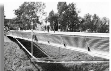
**Bild oberhalb** zeigt die koppelbaren Zugstäbe der Unterspannungskonstruktion. Diese erhöhten zwar die Tragkraft, verminderten allerdings die Durchflusshöhe enorm.
