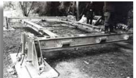
**Bilder oberhalb** zeigen den Grundrahmen. Auf diesem konnte man die Konstruktion händisch bis zu 60 Meter weit vorschieben.
