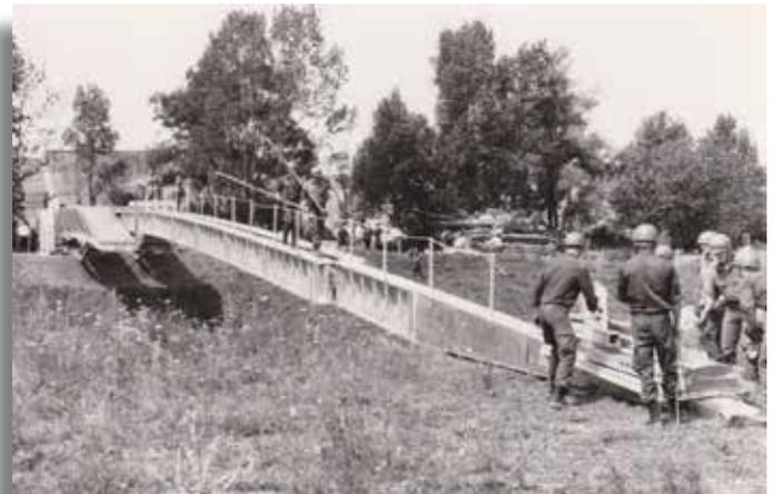
Zum Ergebnis der Erprobung erzählen Beteiligte, dass das System der Brücke durch Einfachheit bestach, der Transport und die Lagerung in mehreren Containern nicht gerade truppentauglich war. „Wir brauchten für das Ausräumen aus den beladenen Containern und dem Einrichten der Baustelle beinahe länger als für den eigentlichen Bau“.
