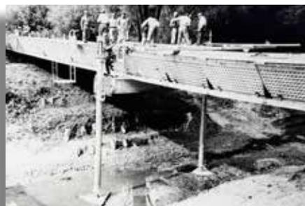
**Bild oberhalb** zeigt von einem weiteren Bau mit einer Alu-Pendelunterstützung. Diese wurde bei den Pionieren eingeführt und jahrelang als Zwischenunterstützung verwendet.
