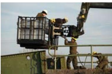
**Bild:** Die bereitgestellte Arbeitsbühne des Teleskopladers mit Soldaten des Pionierbauzuges. Vorsichtig und berührungsfrei wird die Seilverbindung zur Winde des Bergepanzers hergestellt.
