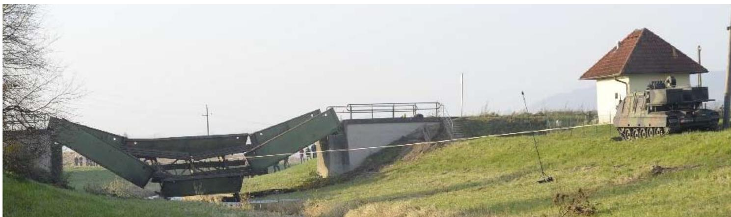
**Bild oben:** Nach der Sprengung der Brücke setzten die Pioniere einen bereitgehaltenen Bergepanzer ein, um mit entsprechendem Zug die Reste des genietetes Fachwerkes sanft abzulegen. (Bild Quelle: ÖBH Gunter Putsch)
