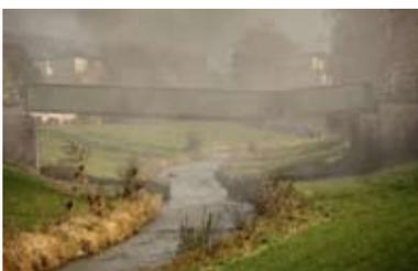
**Bild:** Die in sich verkeilte Brücke nach dem Zünden der Sprengladungen.
