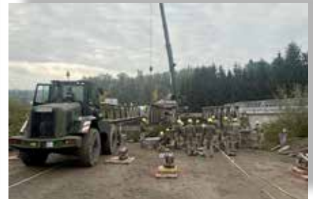
Bilder oben: Zeigen von der sensiblen Phase des Lancierens. Dabei werden die Brücken mittels Kran angehoben und abschnittsweise ein- bzw. ausgeschoben. Für die Bedienung der Krane und der schweren Pioniermaschinen stehen erfahrene Kadersoldaten der Melker Pioniere im Einsatz.
