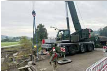
Bilder oben: Zeigen von der sensiblen Phase des Lancierens. Dabei werden die Brücken mittels Kran angehoben und abschnittsweise ein- bzw. ausgeschoben. Für die Bedienung der Krane und der schweren Pioniermaschinen stehen erfahrene Kadersoldaten der Melker Pioniere im Einsatz.
